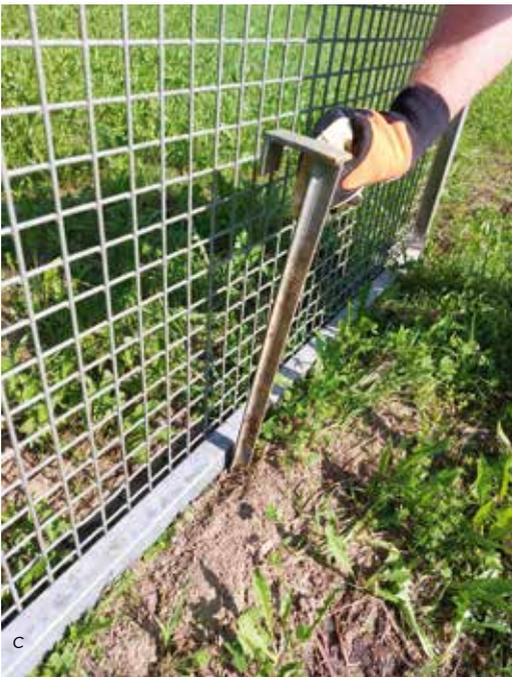
Abbildung 113 a, b, c: Bei selbststehenden Stahlgitterelementen, die über eine geringe oder keine Bodenverankerung verfügen, können diese durch unterschiedliche Verbindungsteile miteinander verbunden werden.
