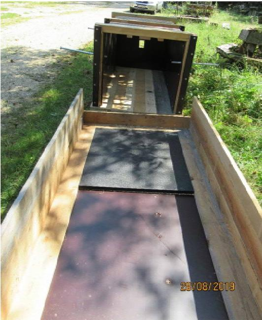
Bild 3: Unterbau (U-Profil) der Kiste
