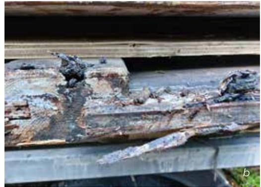
Abbildung 116 a, b: In Abhängigkeit von Standortbedingungen und der Häufigkeit von Standortwechseln kann von einer Haltbarkeit der Fallenerstauführung von 6 - 10 Jahren ausgegangen werden.
