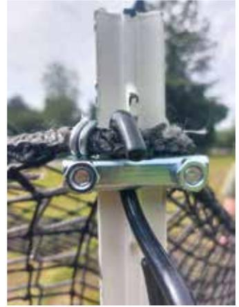
*Befestigung des Netzes an den Pfählen bei der freistehenden Netzvariante*
