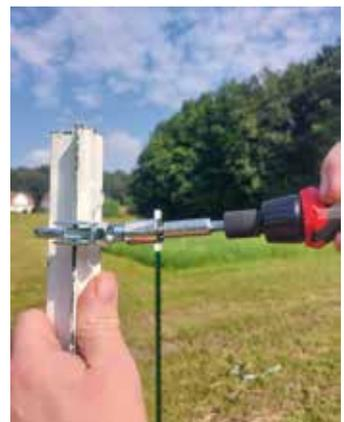
Spanngurthalterung am T-Pfosten
