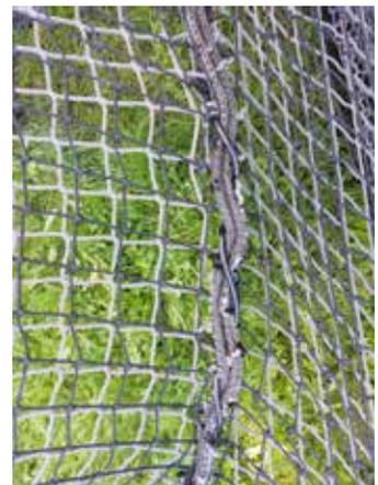
Möglichkeiten der Netzverknüpfung
