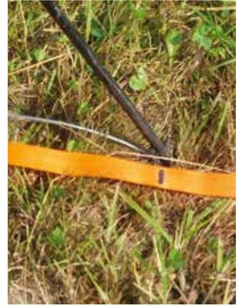
Etablierung des Erdankers zur Pfahlabstützung - Abstandsband in Pfahl einhaken und an der schwarzen Abstandsmarkierung den Erdanker hinter dem Pfahl versenken
