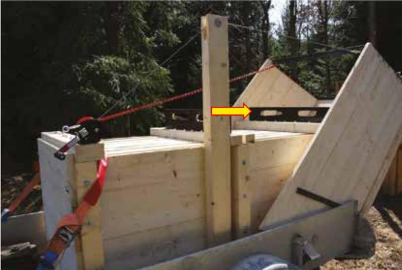
Bild 3 Die Kiste kann durch einsetzbaren Schieber geschlossen werden
