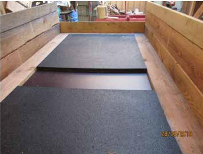
Bild 4: Splitterschutzplatte besteht aus zwei Teilen 3cm dick
