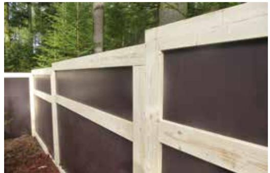
Abbildung 10: Höhenunterschiede können innerhalb der Falle zwischen den einzelnen Modulen jederzeit ausgeglichen werden, so dass die ebenerdige Beschaffenheit nur für jedes einzelne Segment gewährleistet werden muss.
