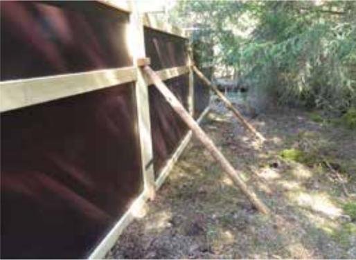
Abbildung 118: Seitliche Verstrebungen unter den Verbindungssegmenten (Kanthölzer) können die Stabilität der Falle weiter erhöhen.
