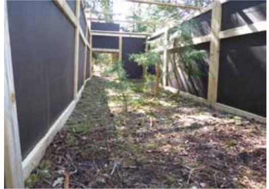
Abbildung 120: Über den Fallenrand gelegte und verschraubte Latten ermöglichen eine zusätzliche Stabilität und bieten die Möglichkeit, entsprechend des Annahmestadiums, die Futterstreuer unterschiedlich zu platzieren.
