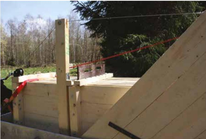
Bild 4 Schieber (Material: Siebdruckplatte) eingesetzt und Rampe ist hochgezogen
