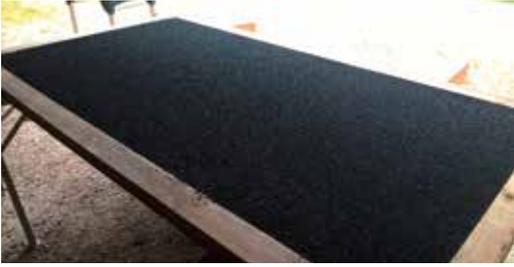
Abbildung 31: Ein mehrschichtiger Geschossfangboden, welcher abwechselnd aus Holzlagen und Geschossfangmatten besteht, wird durch eine vier Zentimeter starke Geschossfanggranulatwanne ergänzt. Dies ermöglicht das Töten der Tiere mit Geschossen bis 2.000 Joule.
